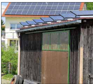
Solaranlagen auf unterschiedlichsten Dächern sind in Hochdorf ein alltäglicher Anblick.
