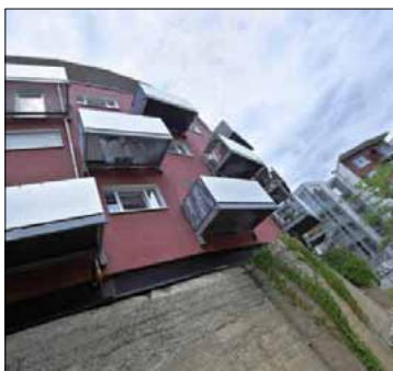
Die „Zwei Zylinder“ genannten Wohnungen an der Ferdinand-Weiß-Straße stehen auf dem Gelände zweier ehemaliger Gaskessel.
