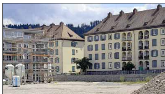
An Komtur- und Kandelstraße stehen alte und neue Gebäude dicht an dicht.
