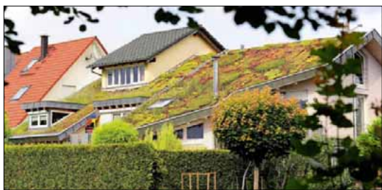
Im Neubaugebiet „Auf der Kinzig“ gibt's was aufs Dach – und zwar gleich eine ganze blühende Wiese.
