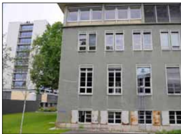
Das etwas andere Herdern: Westlich der Habsburgerstraße gibt es viele Funktionsbauten (wie hier im Uni-Institutsviertel) und einige Wohnblocks.
